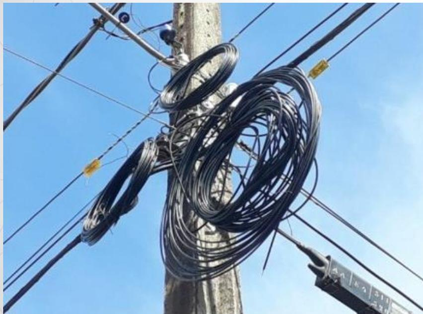
Uso indevido das estruturas de iluminação pública por causar esforço indevido do poste e risco de eletrificação da rede de telecomunicações, podendo causar acidentes fatais
